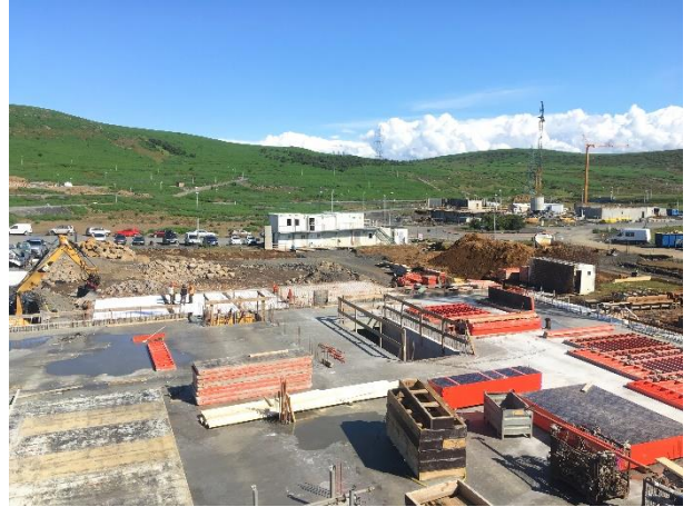
Búið að einangra þakflöt og niðurlögn á torfi hafin á húsluta B (t.v.). Yfirlitsmynd frá þakfleti af húsluta C, búið að steypa plötu yfir 1.hæð í húsluta D og unnið að einangrun og jámbendingu á botnplötu í húsluta E (t.h.).
