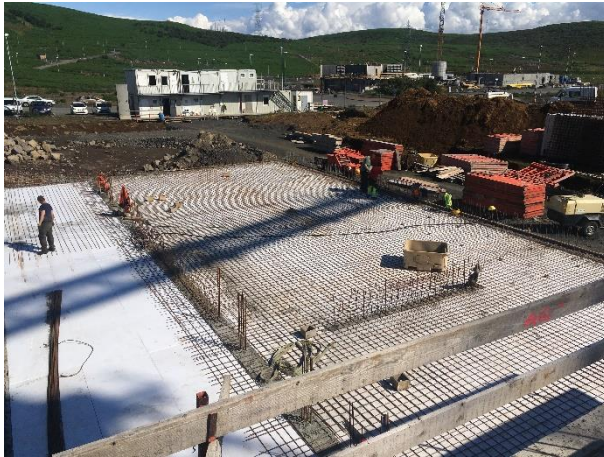
Undirbúningur fyrir steypu á botnplötu í húsi D (t.v.). Bíllaplan að ofanverðu malbikað og tilbúið undir niðurlögn á torfi/gróðursetningu (t.h.).
