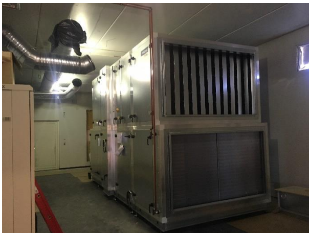
Loftræsisamstæða er komin inn í húshluta C og unnið er að uppsetningu hennar (t.v.). Anddyri í húshluta C, eftir stendur að flísaleggja framán við aðalinngang (t.h.).
