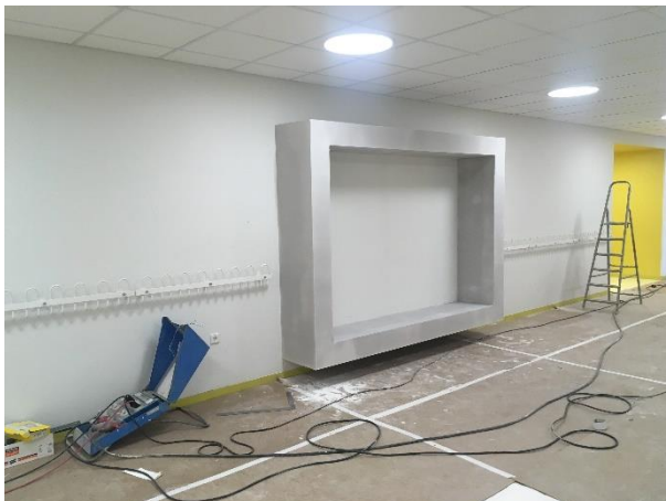
Á 1.hæð í húsluta C er unnið að lokafrágangi, búið er að setja upp léttan vegg til lokunar (til bráðabirgðar).
