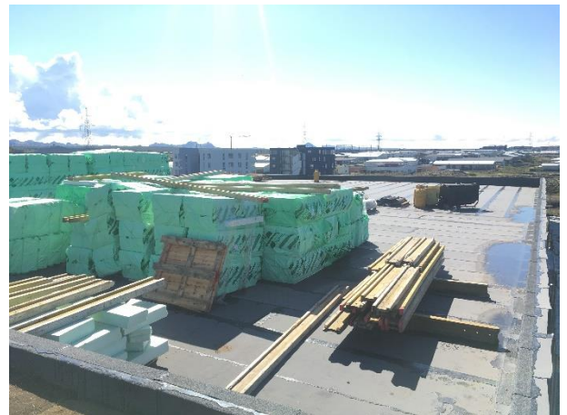
Uppsetning álkæðningar utanhúss vel á veg komin að framanverðu á húsluta C (t.v.) og búið að pappleggja þakflöt á húsluta A (t.h.).
