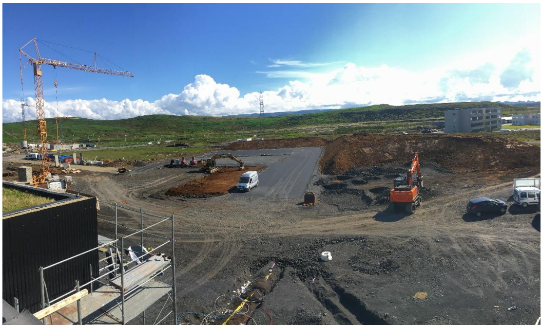
Yfirlitsmynd yfir lóðarfrágang framan við nýbyggingu. Búið að malbika umhverfis sparkvöll/köruboltavöll. Manir tilbúnar undar torflögn og unnið að undirstöðum fyrir leiktæki.
