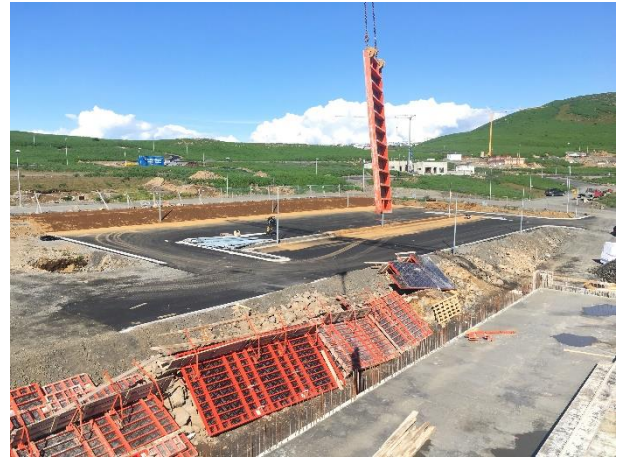
Undirbúningur fyrir steypu á botnplötu í húsi D (t.v.). Bíllaplan að ofanverðu malbikað og tilbúið undir niðurlögn á torfi/gróðursetningu (t.h.).
