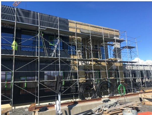
Uppsetning álkæðningar utanhúss vel á veg komin að framanverðu á húsluta C (t.v.) og búið að pappleggja þakflöt á húsluta A (t.h.).
