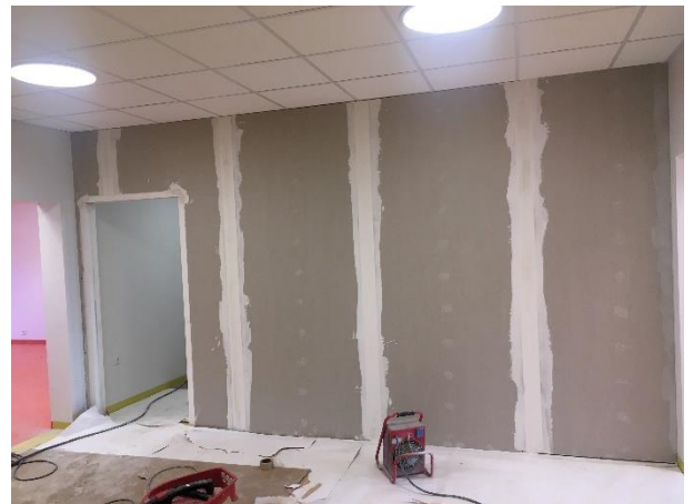
Á 1.hæð í húsluta C er unnið að lokafrágangi, búið er að setja upp léttan vegg til lokunar (til bráðabirgðar).
