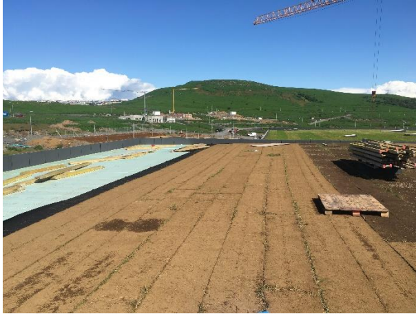
Búið að einangra þakflöt og niðurlögn á torfi hafin á húsluta B (t.v.). Yfirlitsmynd frá þakfleti af húsluta C, búið að steypa plötu yfir 1.hæð í húsluta D og unnið að einangrun og jámbendingu á botnplötu í húsluta E (t.h.).
